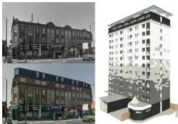
Рисунок 1. Реконструкция кровли и облицовки
