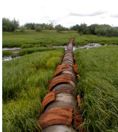
Рисунок 1 – Всплытие трубопровода
