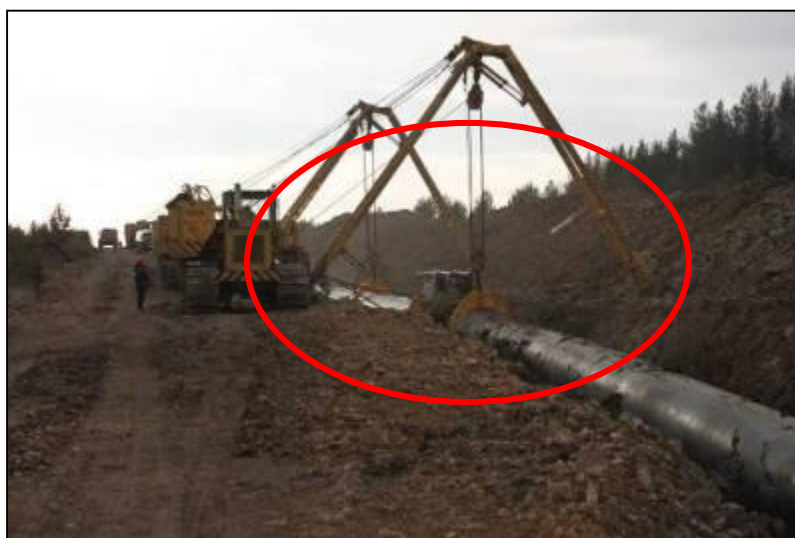
Рисунок 4. Подъем участка газопровода трубоукладчиками, красным отмечено место возникновения повышенных изгибных нагрузок
