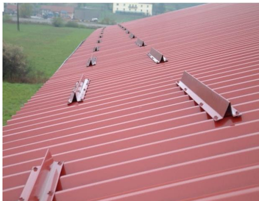
Рисунок 2. Пластинчатый снегозадержатель
