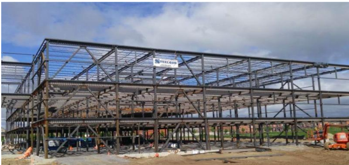
Рис. 6. Рамный каркас промышленного здания в г. Алматы с применением двутавров с гофрированной стенкой
