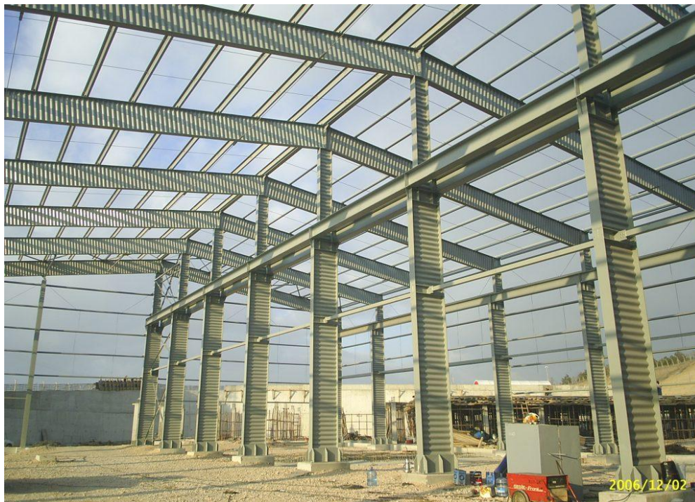
Рис. 2. Рамный каркас из двутавров с гофрированной стенкой
