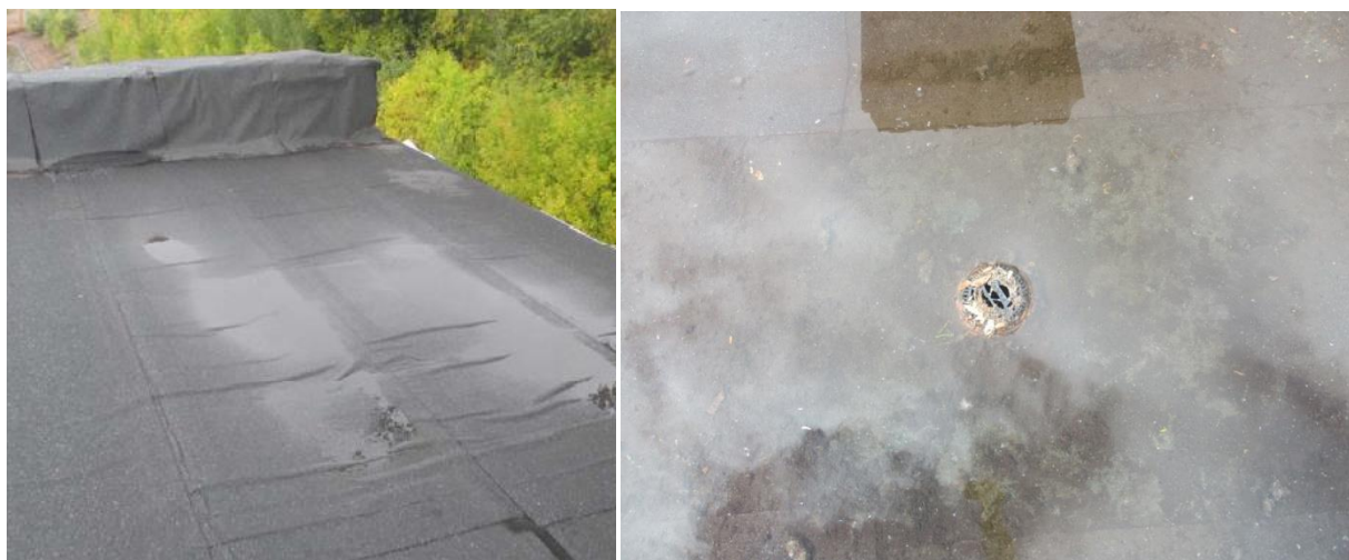
Рис. 1 а) застой воды на кровле из-за нарушения уклона и «продавливания» материалов на отдельных участках покрытия; б) – засорение водоприемной воронки
