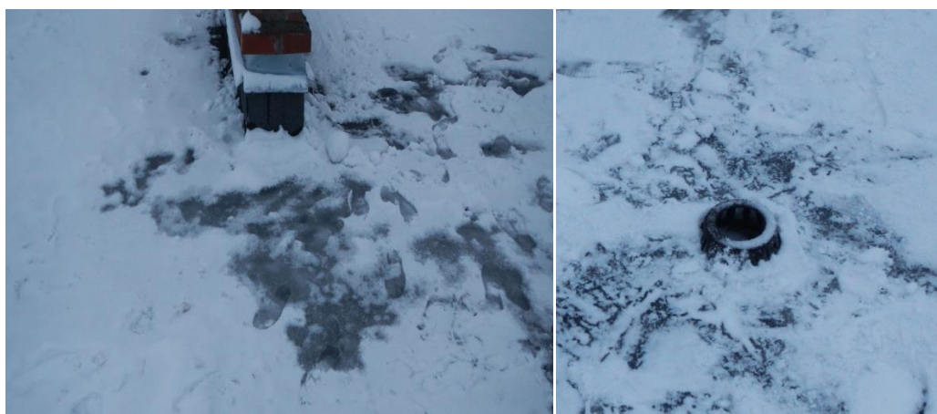
Рис. 2 а) образование корки льда в результате неправильной эксплуатации технического этажа; б) образование валика льда вокруг водоприемной воронки
