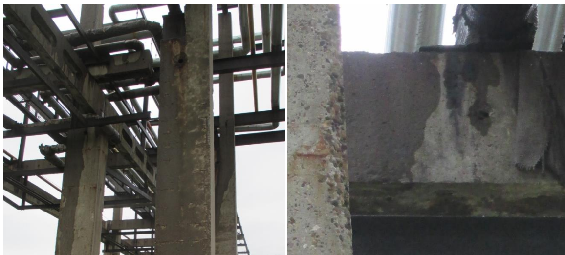
Рис. 3 а) замачивание конструкций из-за протечек инженерных коммуникаций; б) разрушение бетона траверсы по форме протекающей трубы
