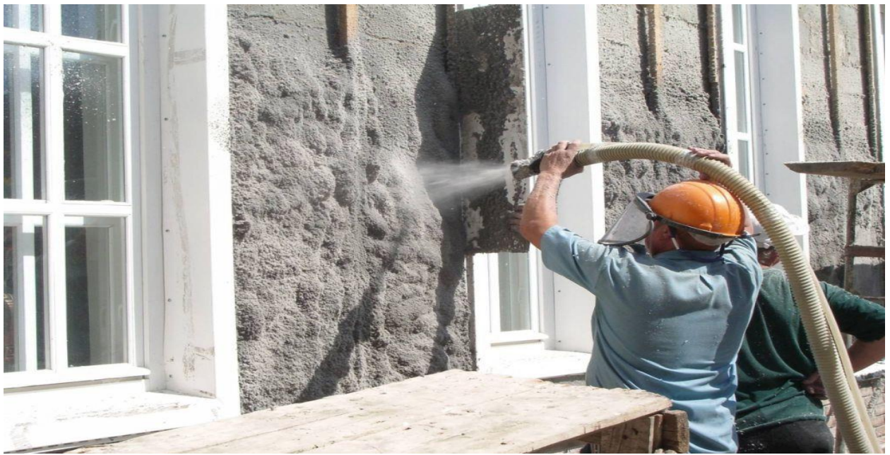
Рис.3 Утепление стен эковатой
