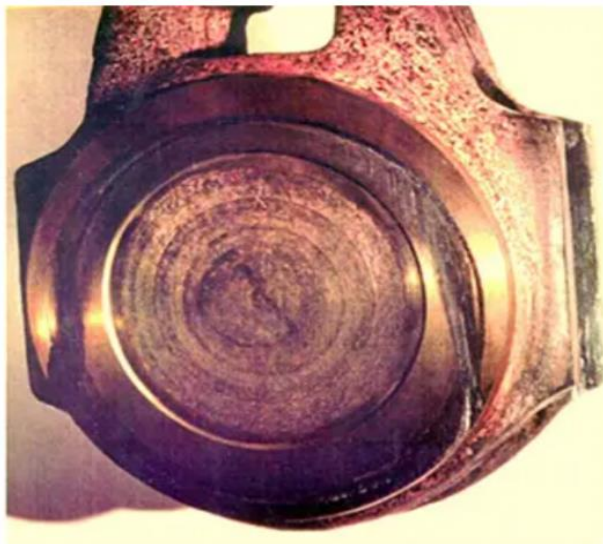
а) повреждение ниже по течению поверхности посадочной поверхности затвора
