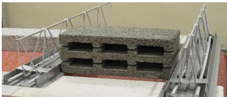
Рисунок 3 – Перекрытие с керамзитобетонными блоками
