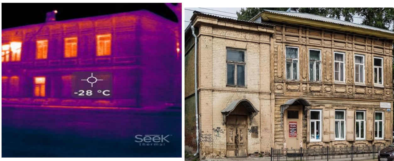
Рис. 1. Многоквартирный дом, по адресу Степана Разина 15. Построен в 1917 году. На фотографиях видно, что выход тепла брусового дома, также из под плохо утепленной крыши.
