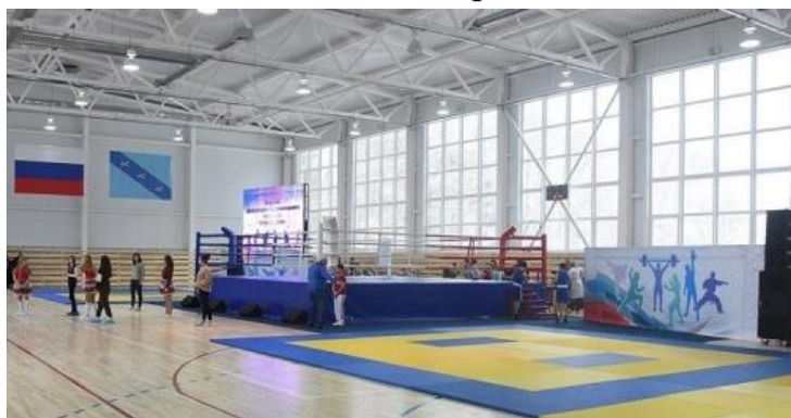
Рисунок 2. Применение ферм типа «Молодечно» а) ФОК г. Курск б) ТЦ «Гипер Лента» г. Курск
