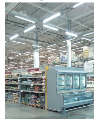
Рисунок 2. Применение ферм типа «Молодечно» а) ФОК г. Курск б) ТЦ «Гипер Лента» г. Курск
