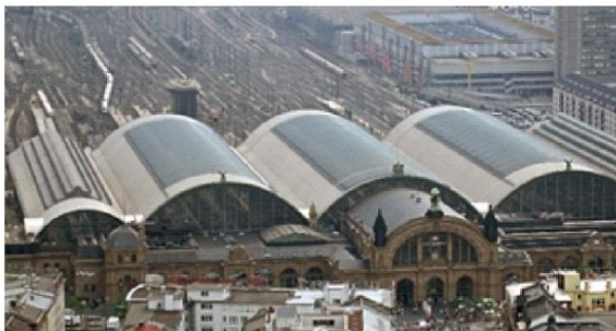
Рис.2 – Покрытия цилиндрическими оболочками: а – центральный вокзал, г. Франкфурт, Германия [7]; б – центральный рынок, г. Воронеж [8]
