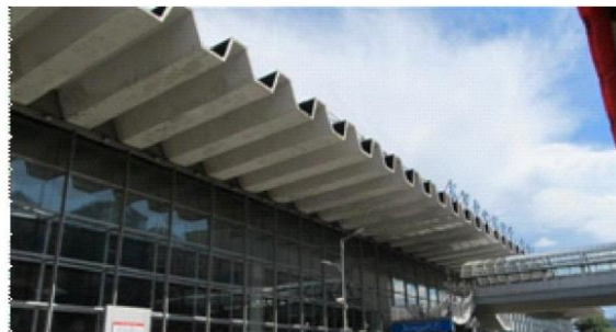
Рис. 4 – Складчатое покрытие: а – главный вход вокзала, г. Лиссабон, Португалия [9]; б – Курский вокзал, г. Москва [3]
