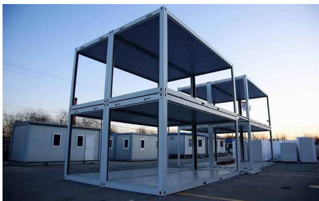
Рис. 1. Металлический каркас блок-модуля
