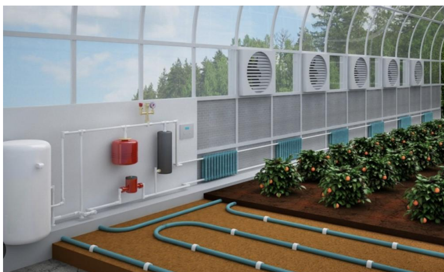
Рисунок 1. Схема водяного обогрева теплицы
